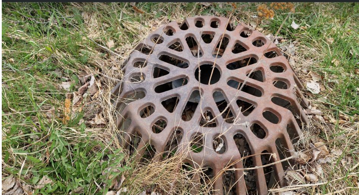
Figur 6 – Bilder av eksisterende sluk og stikkrenne ved Røyskattlie 15. Sluk og slukrist skal beholdes, men stikkrenne må legges om pga ny nettstasjon, se tegning Z-20-02. (Norconsult Norge AS)
